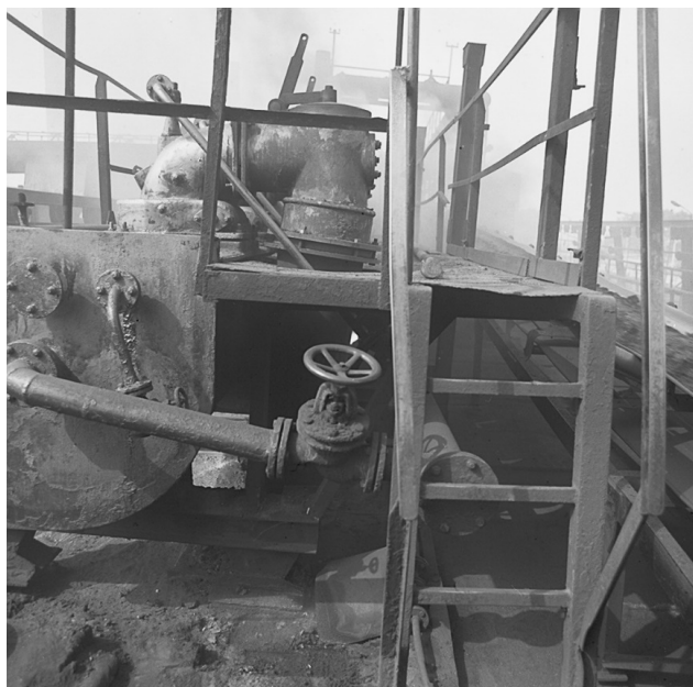
Rura odciągowa i odbieralnik gazu, lata 60. XX wieku, ze zbiorów JSW KOKS Zabrze
