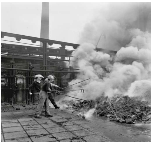
Gaszenie i rozbijanie wypchniętego koksu, lata 60. XX wieku, ze zbiorów JSW KOKS Zabrze
