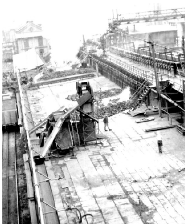
Rampy poziome baterii nr II i III z przebudowanymi przenośnikami taśmowymi lata 50. XX wieku, ze zbiorów JSW KOKS Zabrze
