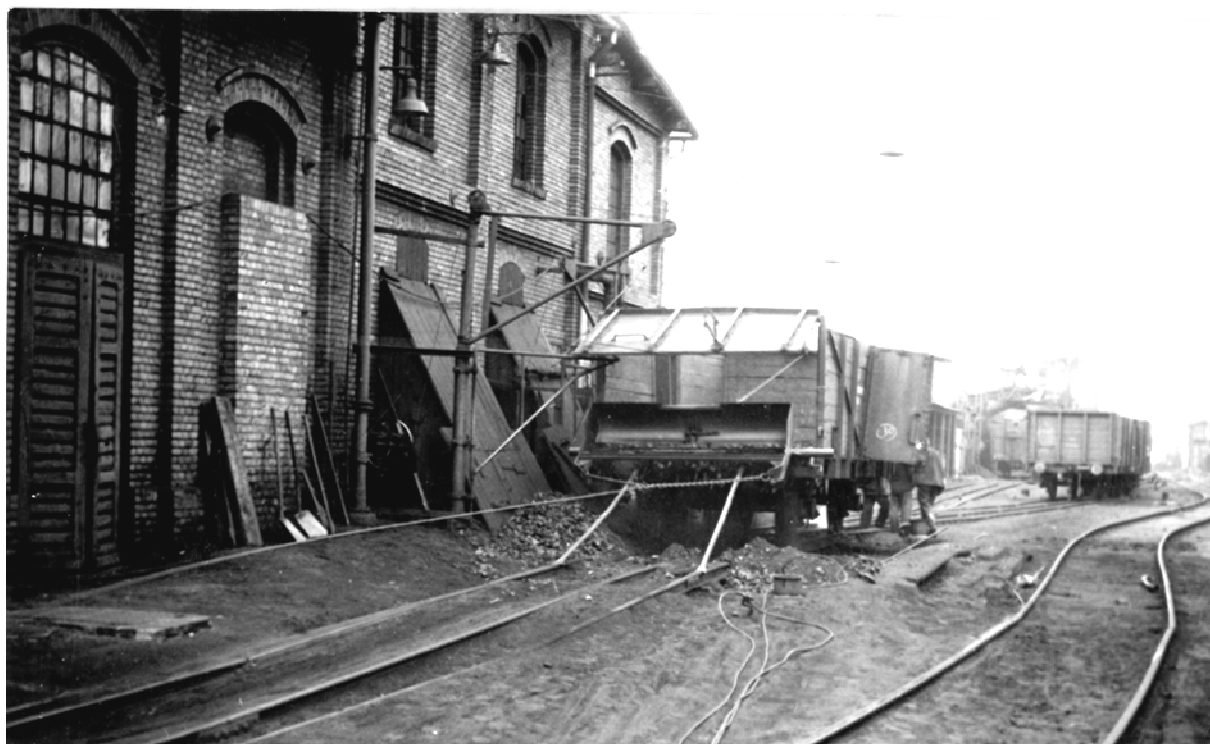
Mechaniczny wyładunek węgla z wagonów kolejowych, lata 50. XX wieku, ze zbiorów JSW KOKS Zabrze
