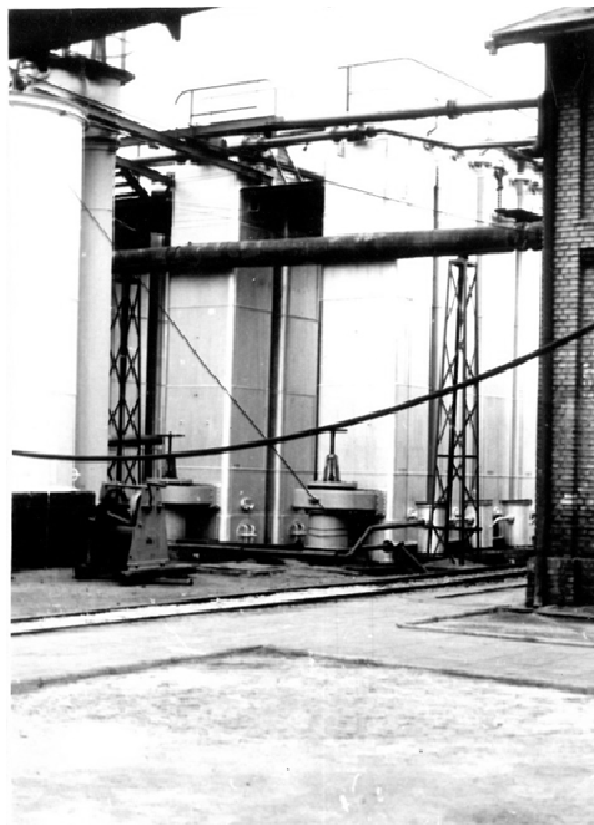
Wodnorurkowe chłodnice gazu koksowniczego, lata 50. XX wieku, ze zbiorów JSW KOKS Zabrze
