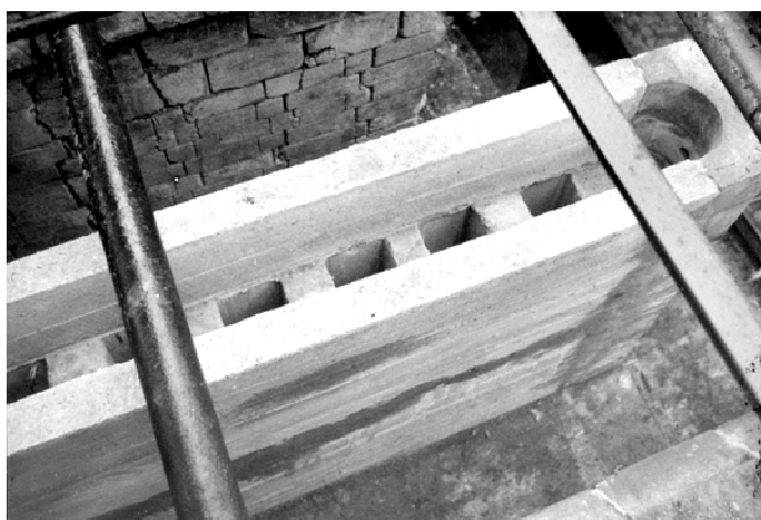
Wykonana z betonu ściana grzewcza baterii koksowniczej, widoczne są kanały grzewcze i kanał przewalowy lata 70. XX wieku, ze zbiorów Muzeum Górnictwa Węglowego w Zabrzu
