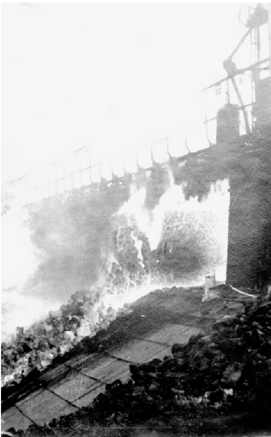
Wypychanie koksu na rampę skośną, lata 50. XX wieku, ze zbiorów JSW KOKS Zabrze
