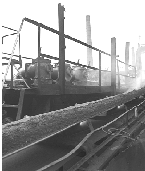
Strop baterii koksowniczej z przenośnikiem taśmowym transportującym węgiel lata 60. XX wieku, ze zbiorów JSW KOKS Zabrze
