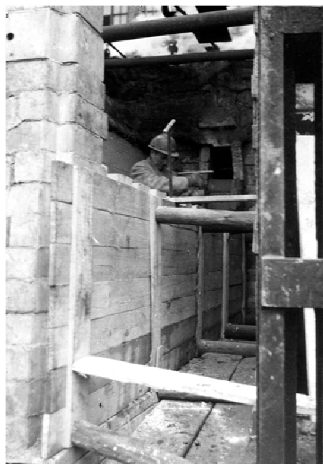
Budowana z betonu ściana baterii koksowniczej, lata 70. XX wieku, ze zbiorów Muzeum Górnictwa Węglowego w Zabrzu
