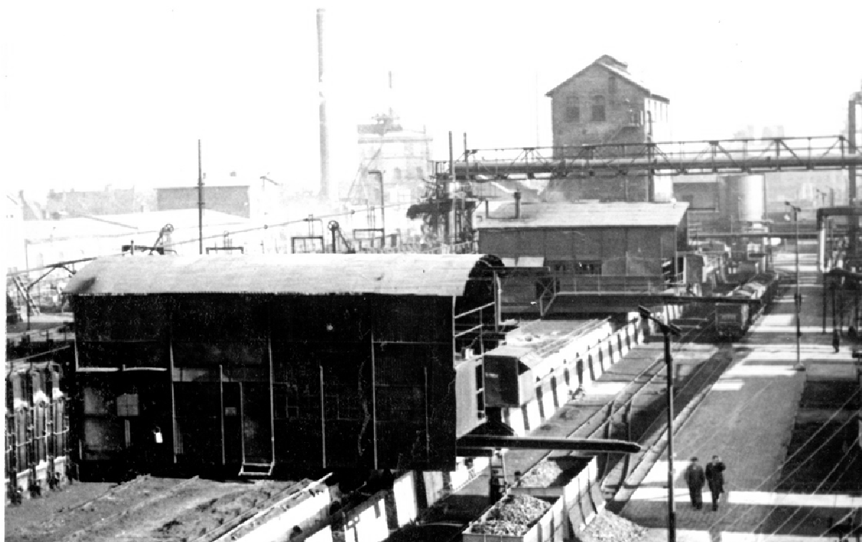
Baterie koksownicze, na pierwszym planie wsadnica o napędzie elektrycznym na drugim wsadnica parowa, lata 50. XX wieku, ze zbiorów JSW KOKS Zabrze
