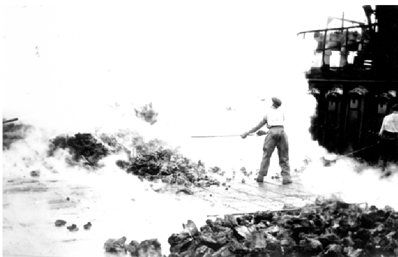
Rozgarnianie gorącego koksu, lata 50. XX wieku, ze zbiorów JSW KOKS Zabrze
