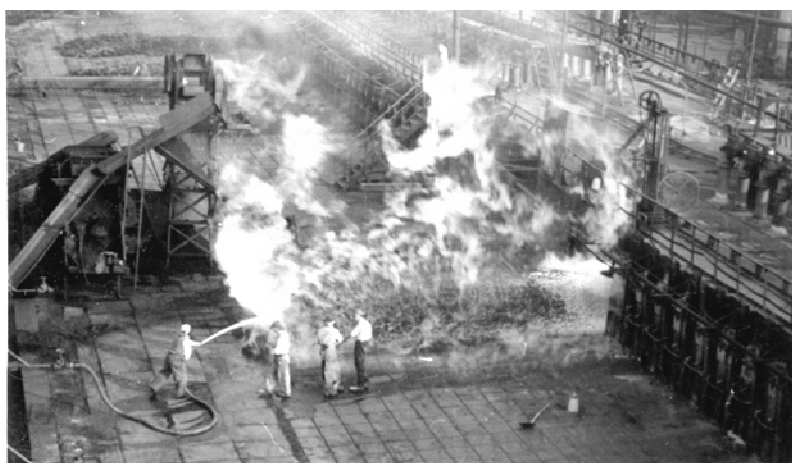
Wypychanie koksu na rampę płaską, lata 50. XX wieku, ze zbiorów JSW KOKS Zabrze
