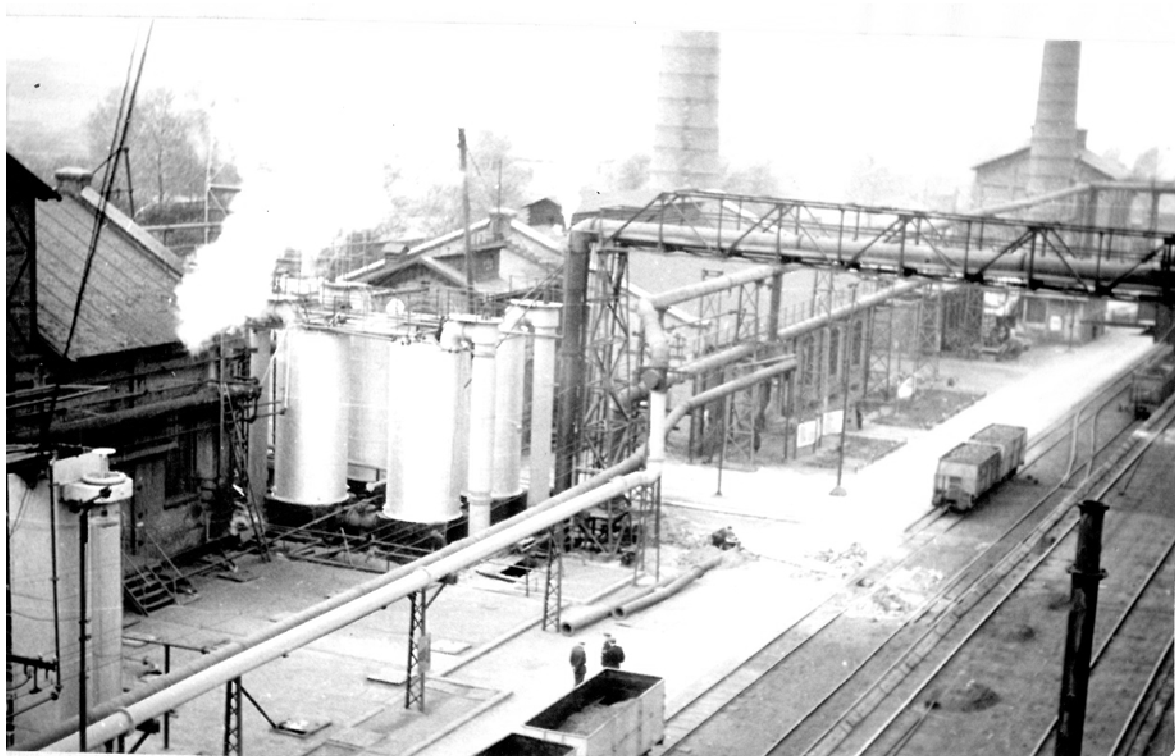
Chłodniki powietrzne gazu koksowniczego, lata 50. XX wieku, ze zbiorów JSW KOKS Zabrze
