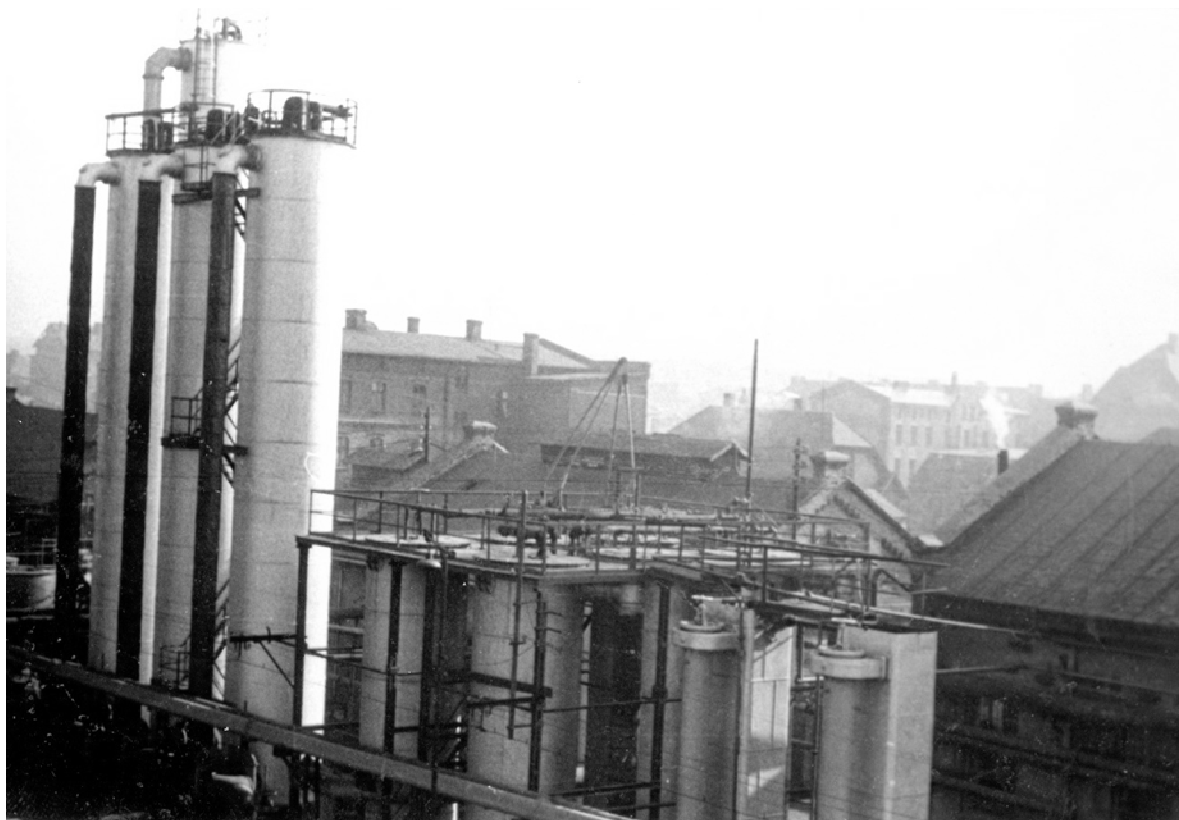
Chłodniki powietrzne, płuczki amoniakalne i benzolowe, lata 50. XX wieku, ze zbiorów JSW KOKS Zabrze
