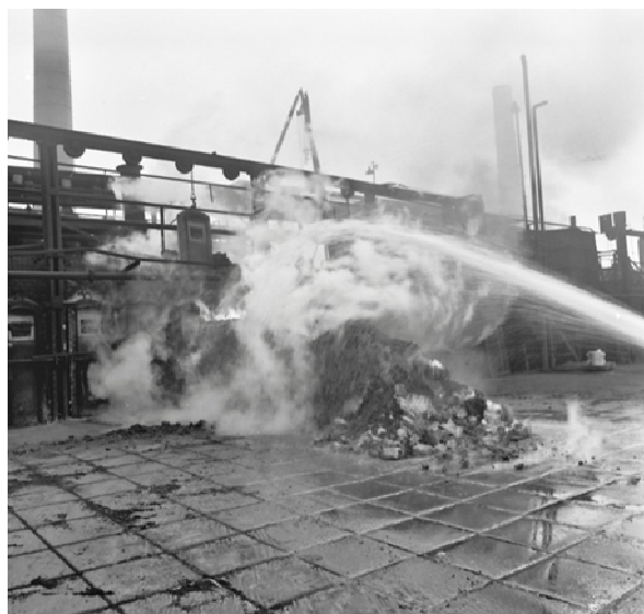
Gaszenie i rozbijanie wypchniętego koksu, lata 60. XX wieku, ze zbiorów JSW KOKS Zabrze
