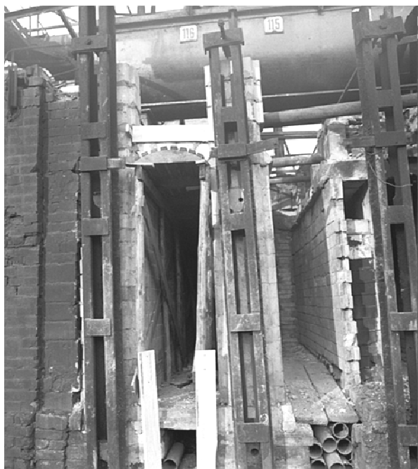
Remont baterii koksowniczej, lata 60. XX wieku, ze zbiorów JSW KOKS Zabrze
