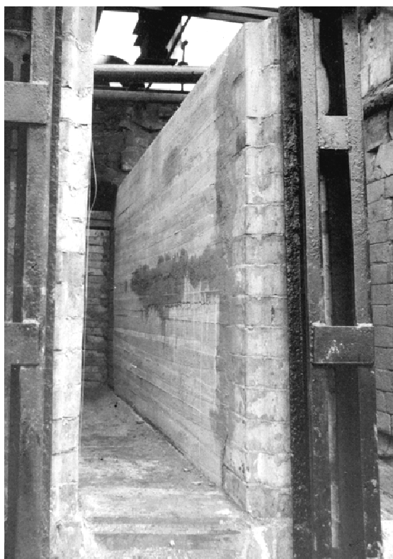
Wykonana z betonu ściana baterii koksowniczej, lata 70. XX wieku, ze zbiorów Muzeum Górnictwa Węglowego w Zabrzu
